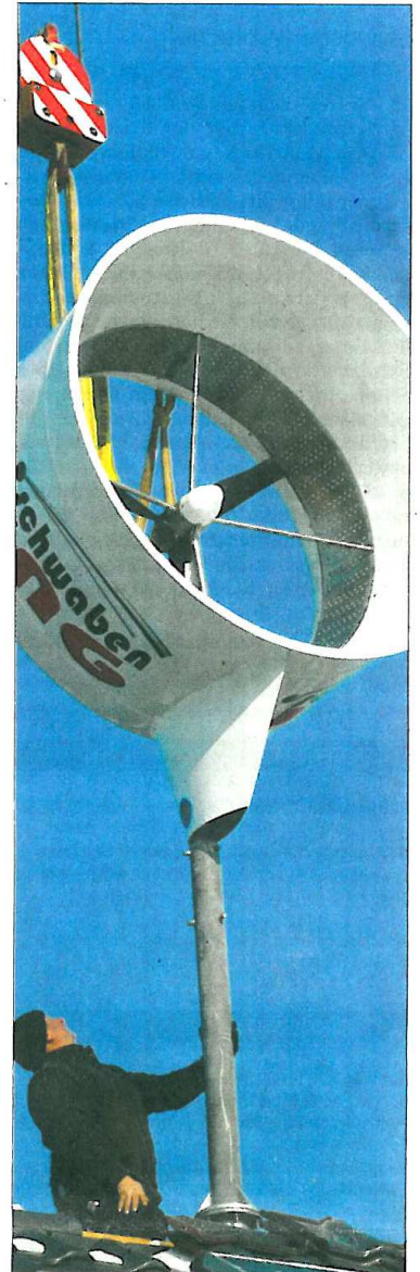
Die Turbine ist an Ort und Stelle angekommen. Sie wird fest verschraubt – und kann auch Stürmen standhalten. Foto: z
